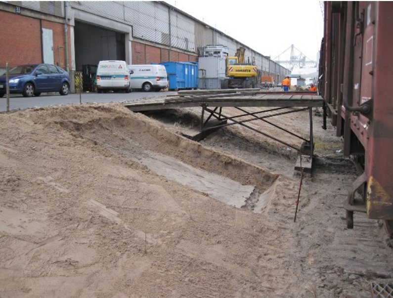
Im Herbst 2011 wurde die Böschung neu gestaltet
