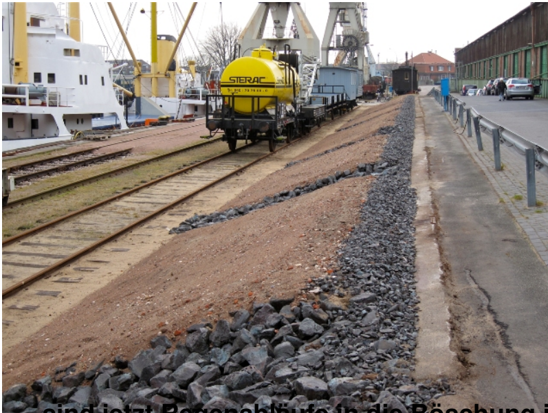
...sind jetzt Regenabläufe in die Böschung integriert
