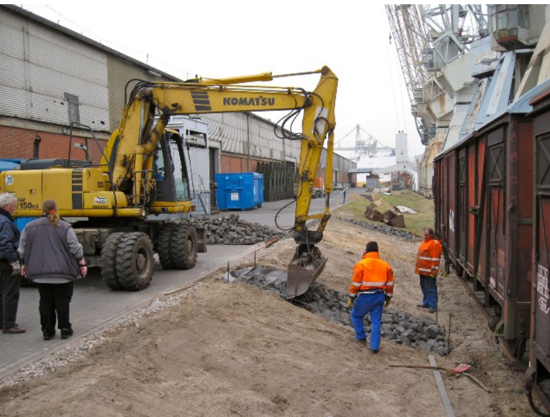
Da bei Regen immer wieder Sand ins Gleis gespült wurde...
