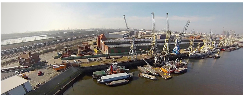
Luftbild Bremer Kai im Süden bis zum Einfahrtbogen
