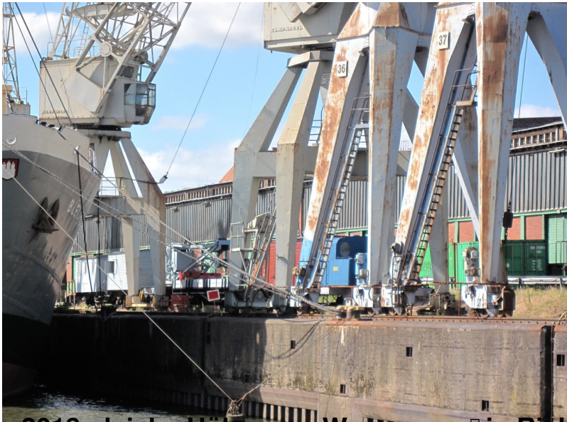
2018 gleiche Höhe vom Wasser aus in Richtung Süden
