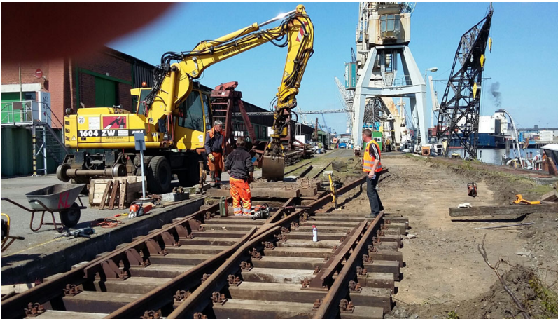
Weiche 3 gleich hinter dem Einfahrtbogen...
