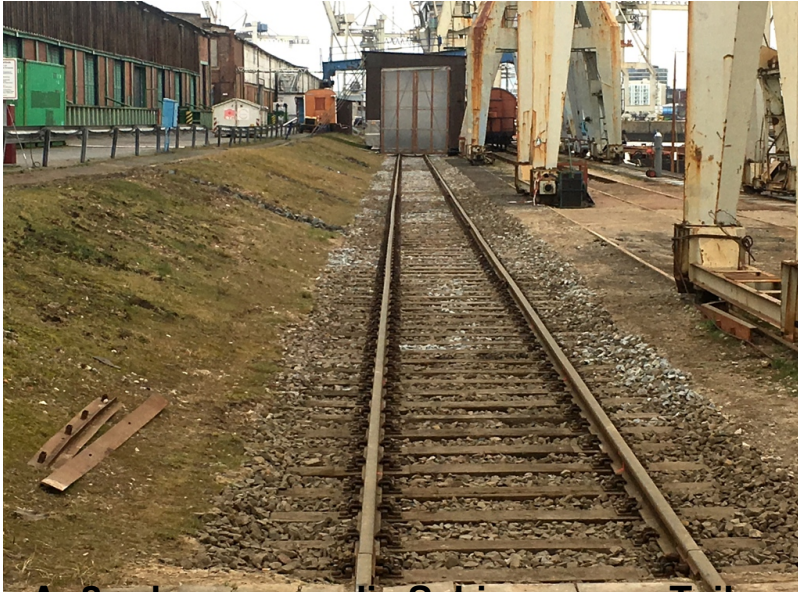
Außerdem waren die Schienen zum Teil noch genagelt und einige Nägel konnten
