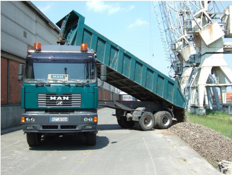
Abladen des Schotters, ebenfalls von der Dalmannstraße
