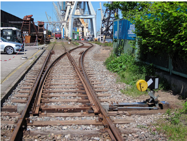
Fertig, vom Einfahrtbogen (Süden) aus gesehen
