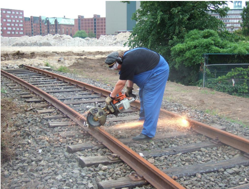
Zerteilung der Schienen in Gleisjoche an der Dalmannstraße
