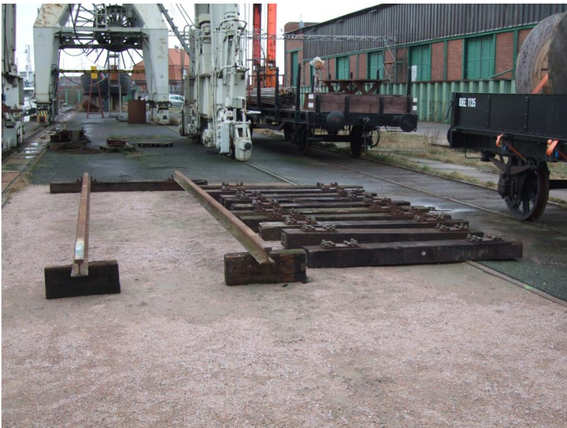
Herstellung eines gesonderten Gleisjochs...
