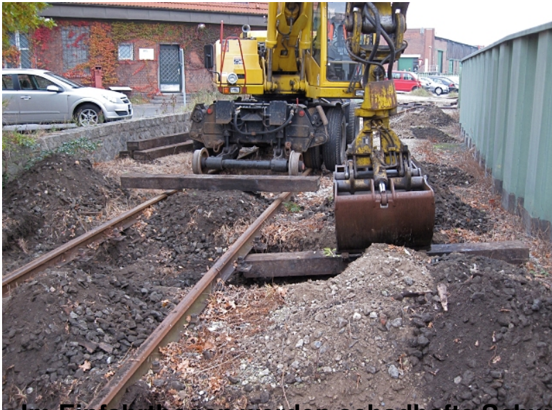
Im Einfahrtbogen werden schadhafte Schwellen ersetzt
