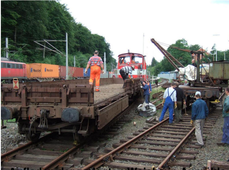
Aufladen der zerlegten Weiche in Aumühle mit historischem Schienenkran auf Fla
