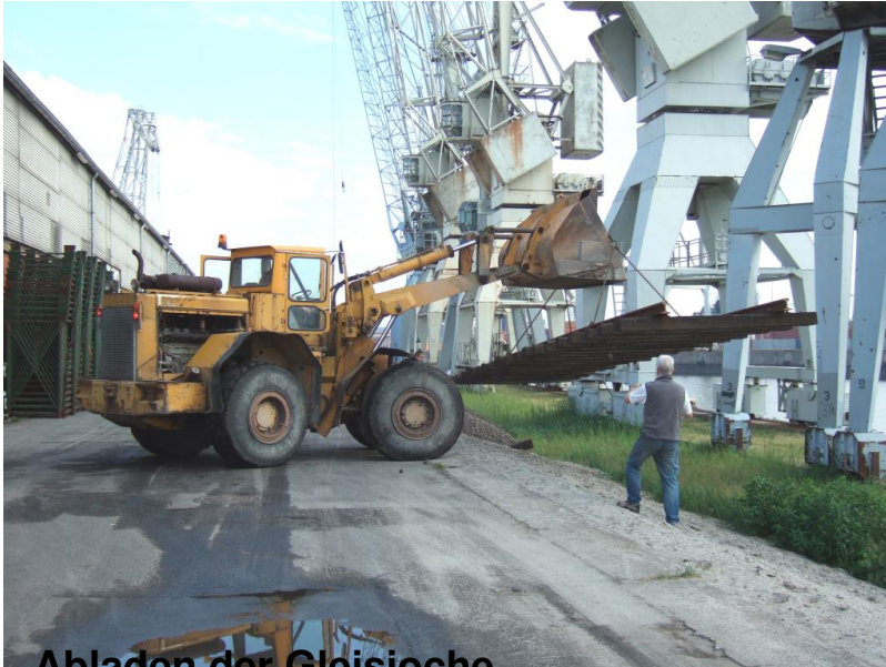
Abladen der Gleisjoche
