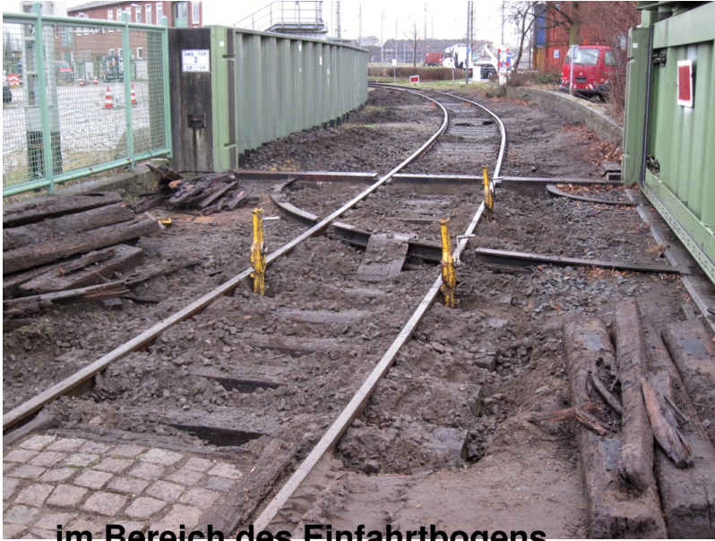
...im Bereich des Einfahrtbogens...
