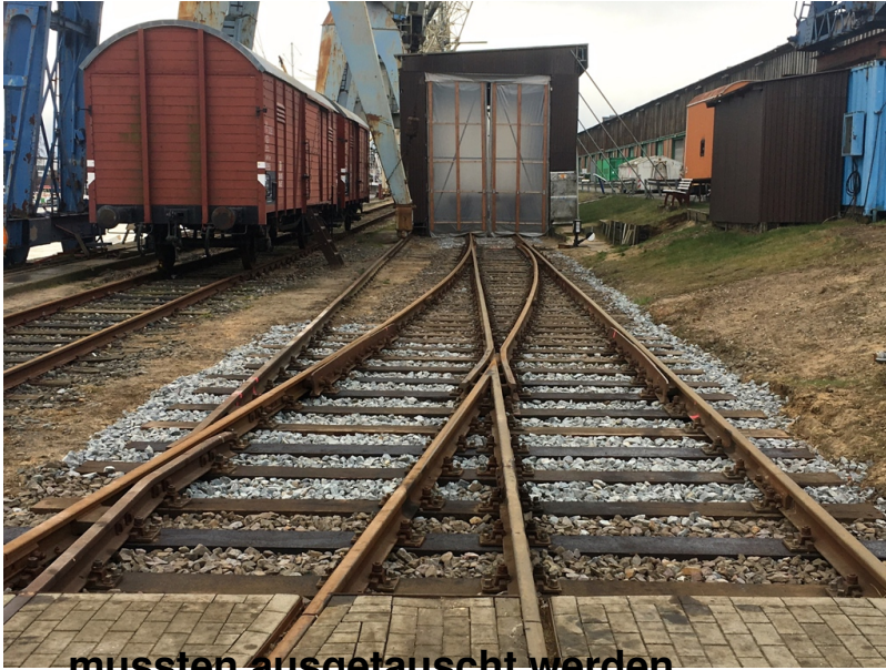
...mussten ausgetauscht werden.
