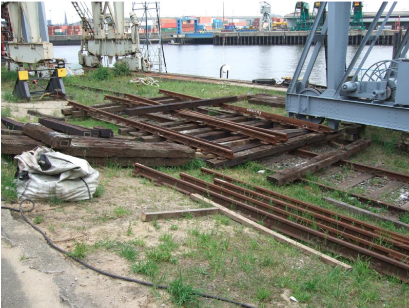
Zusammenbau der Weiche an der historischen Kaikrankreuzung
