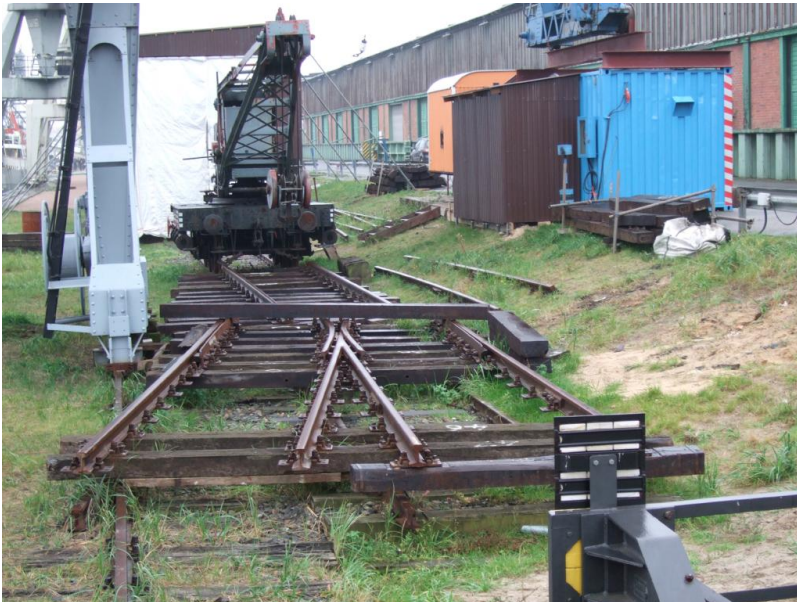
Ohne unseren Schienenkran Mainz wäre der Zusammenbau der Weiche unmöglich
