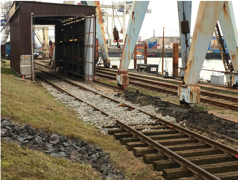
Im Frühjahr 2019 musste das Gleisstück zwischen der MS Bleichen und dem "Wag
