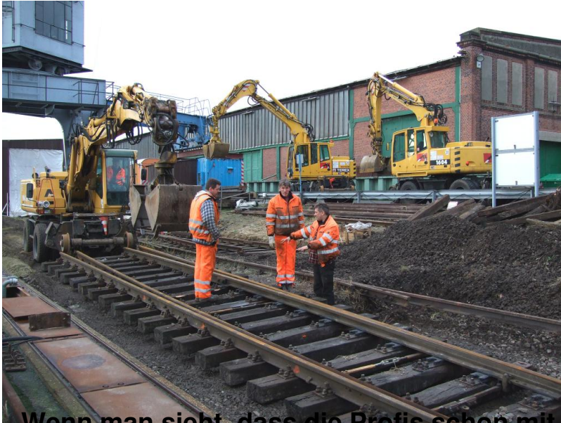
Wenn man sieht, dass die Profis schon mit drei Baggern anrücken...
