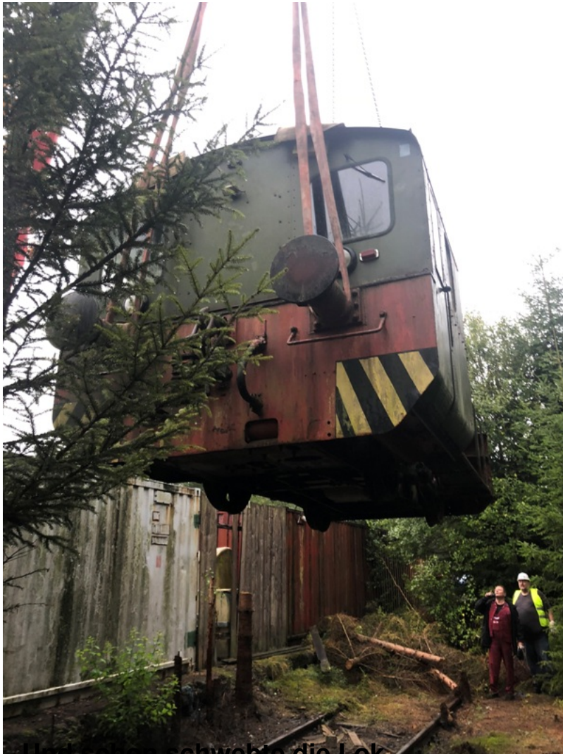
Und schon schwebte die Lok...
