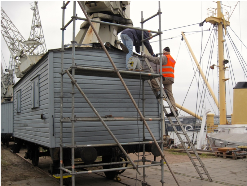
In 2016 haben wir das Dach komplett neu eindecken müssen...
