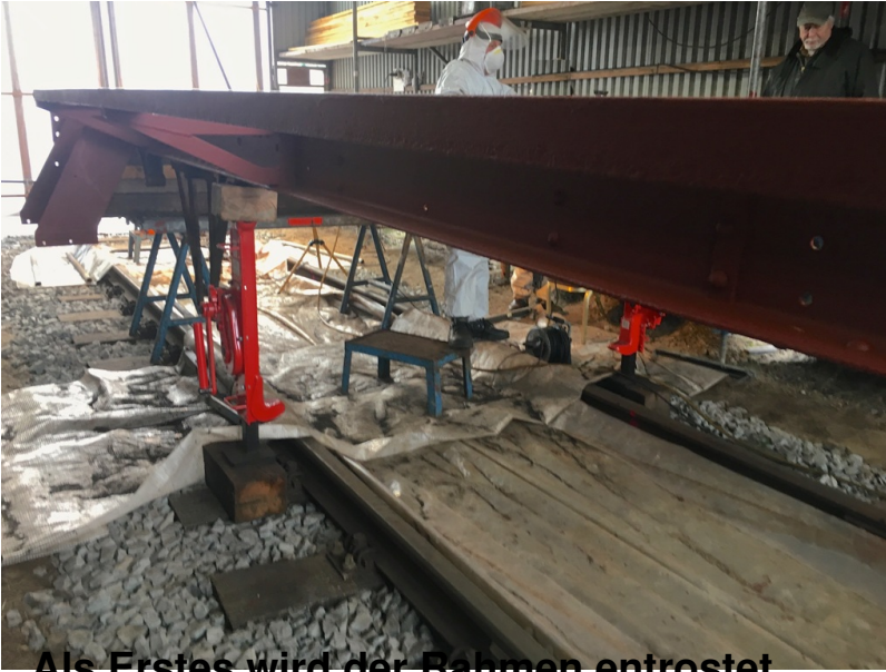
Als Erstes wird der Rahmen entrostet...
