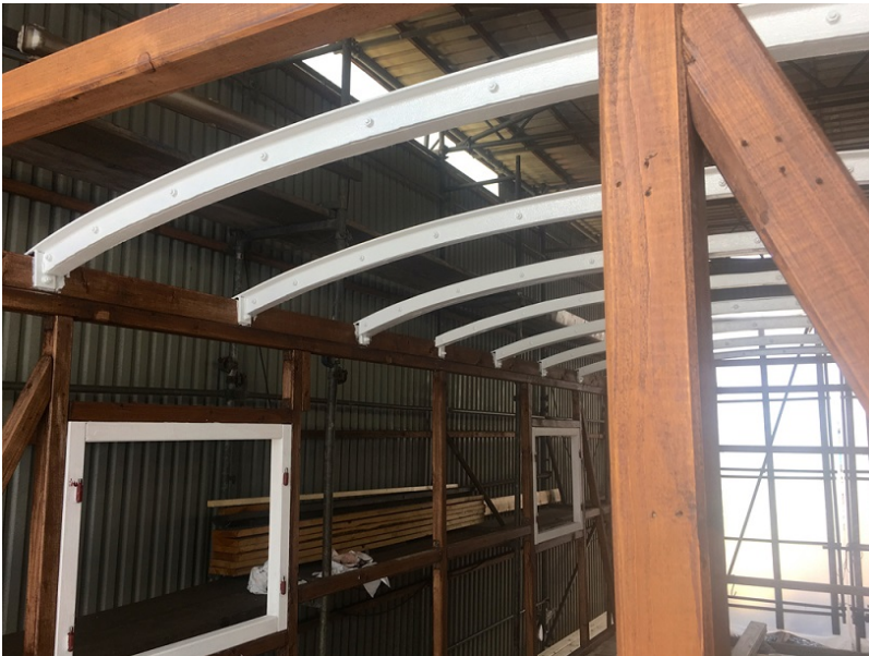
...und die Dachsparren neu erstellt...
