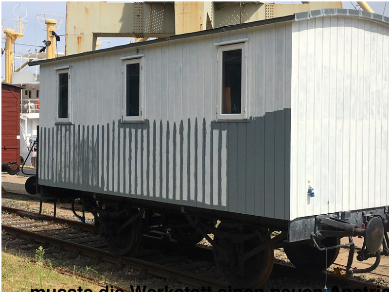
...musste die Werkstatt einen neuen Anstrich...
