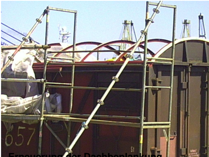
Erneuerung der Dachbeplankung
