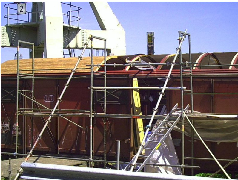
Erneuerung der Dachbeplankung
