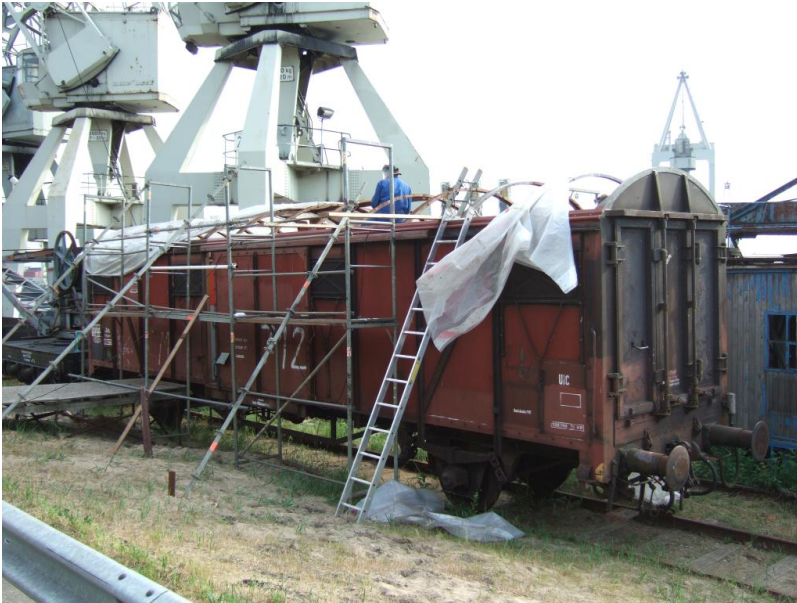
Das provisorische Dach, sowie die verrottete Dachbeplankung werden entfernt
